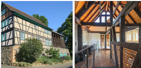
nachher – Außenansicht und Ansicht des ausgebauten Dachgeschosses
